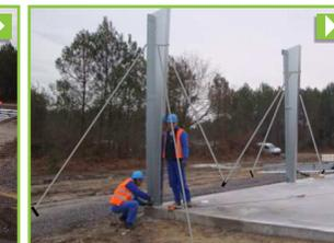
Levage et fixation des poteaux.
