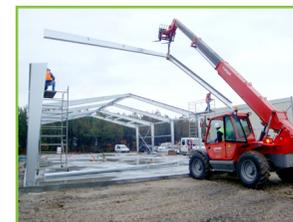
Mise en place des pannes préassemblées au faîtage et fixation sur les poteaux.
